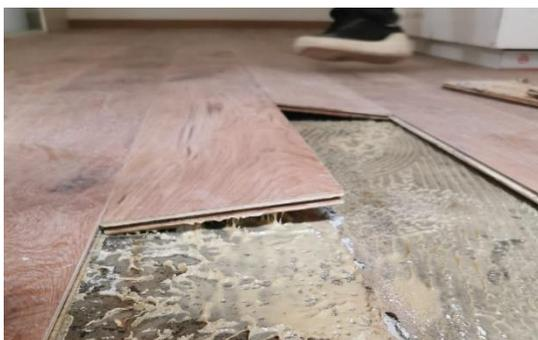
"Tapeteo" de madera por falta de junta de expansión a muros o exceso de humedad en el ambiente.
